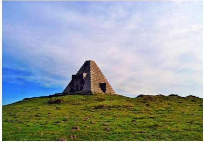
Figura 2: Estado actual de la poderosa estructura maclada del mausoleo.
