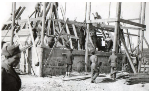
Figura 10: Estado inicial de las obras de la pirámide con el basamento ya levantado (Génova, Archivo della Provincia di Genova dei Frati Minori Cappuccini).
