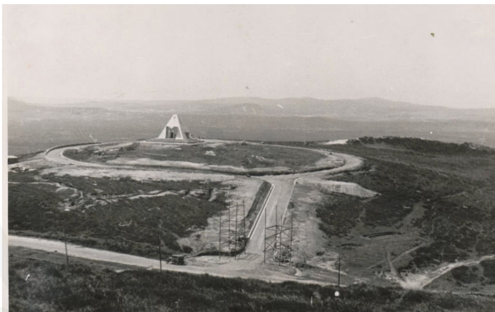
Figura 8: Fotografía del santuario con la portada en construcción (Génova, Archivo della Provincia di Genova dei Frati Minor Cappuccini).
